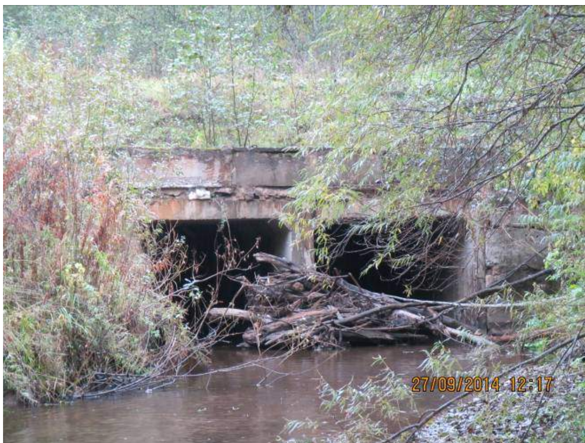
Рисунок 24 – Пропуск реки Крутовки через трубы под автомобильной дорогой д. Ямищи – д. Тухомичи [22].
